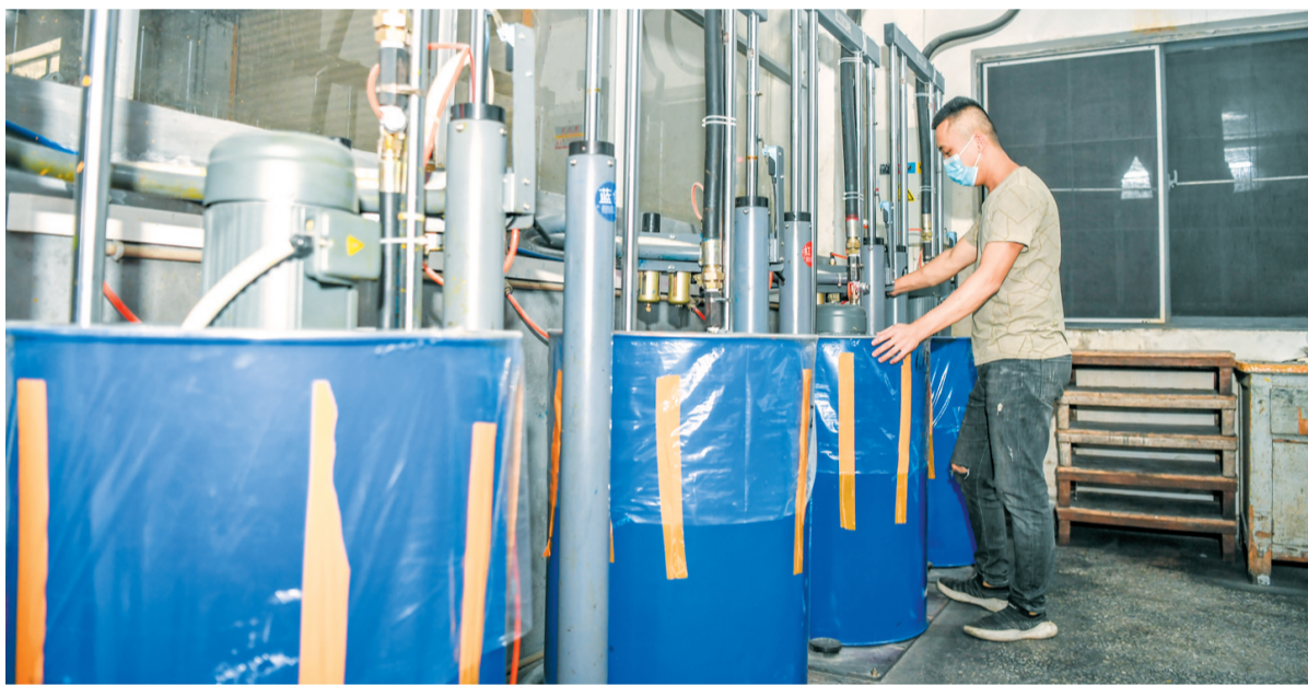
3月14日,在海口新明印刷有限公司,工作人员调试油墨供应系统。 本报记者 孙士杰 摄
