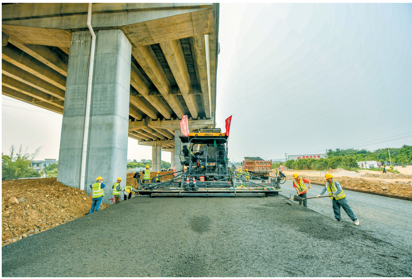
近日,在G15市政道路项目,施工人员正在铺设道路水稳层。 本报记者 孙士杰 摄
