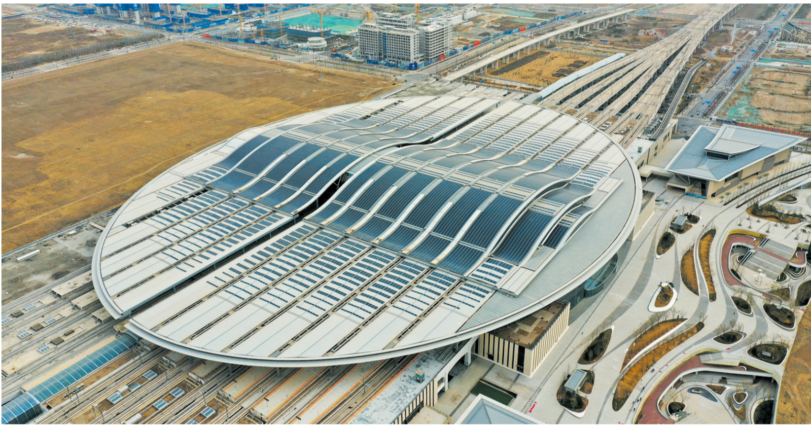
这是京雄城际铁路雄安站(2023年3月23日摄,无人机照片)。新华社记者 牟宇 摄
