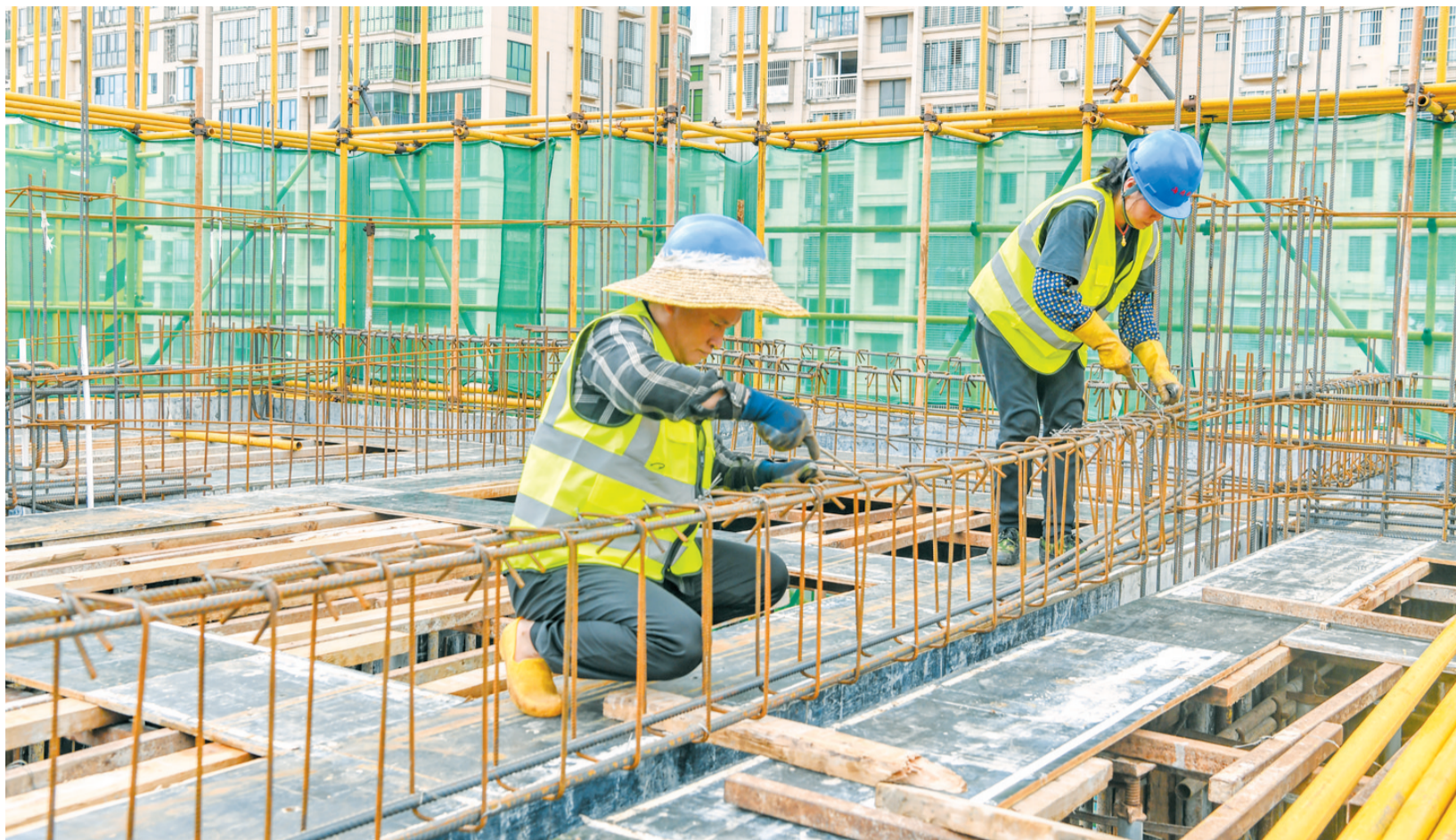
5月22日,在龙华区海云鞋厂宿舍区自主改造项目,施工工人正在绑扎钢筋。 本报记者 孙士杰 摄
