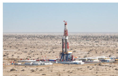
图为5月30日拍摄的“深地塔科1井”(无人机照片)。
