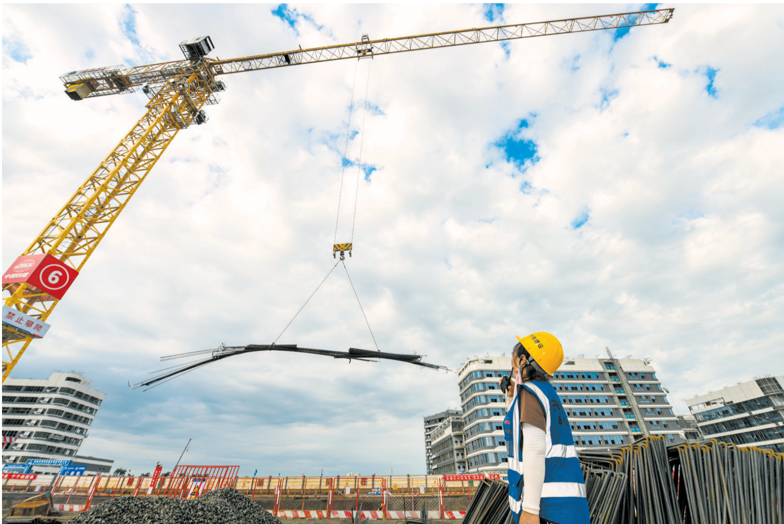
8月13日,在海南医学院桂林洋新校区(一期)项目现场,施工人员正在吊运钢筋。 本报记者 苏弼坤 摄
