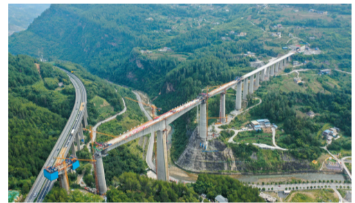
这是8月24日拍摄的石梁河双线特大桥4号墩T构桥梁合龙施工现场（无人机照片）。
