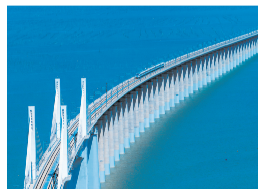
一列运行试验车组驶过福厦高铁湄洲湾跨海大桥(9月19日摄,无人机照片)。
