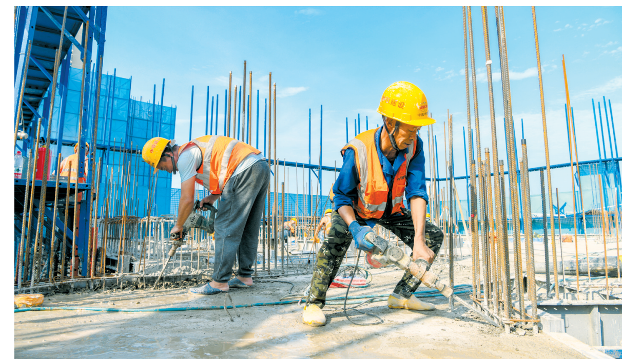
10月6日，在琼山区博雅片区(一期)城市更新项目现场，施工人员在施工。本报记者 苏弼坤 摄
