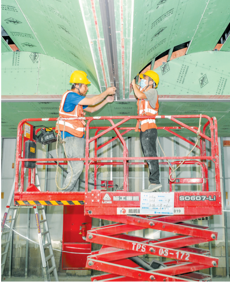
▶10月23日,施工工人正在安装综合实训楼吊顶。
