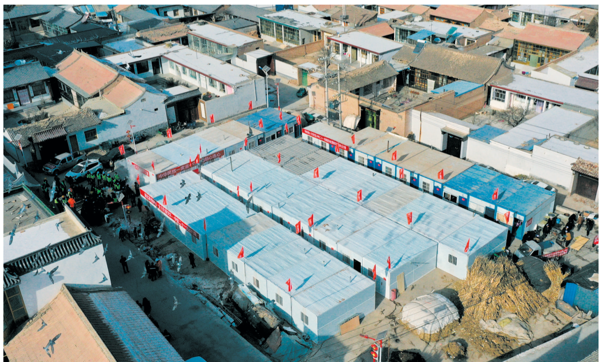
这是12月22日拍摄的积石山县大河家镇梅坡村活动板房安置点(无人机照片)。 新华社记者 陈斌 摄
