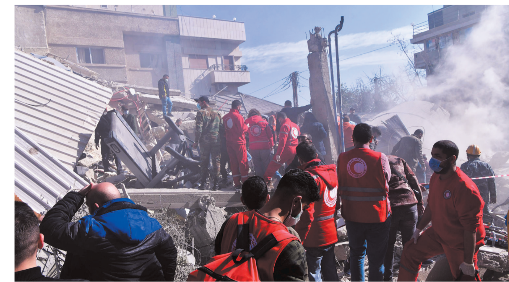
1月20日,叙利亚首都大马士革西部迈宰地区一栋多层住宅楼遭袭,救援人员来到现场救援。
