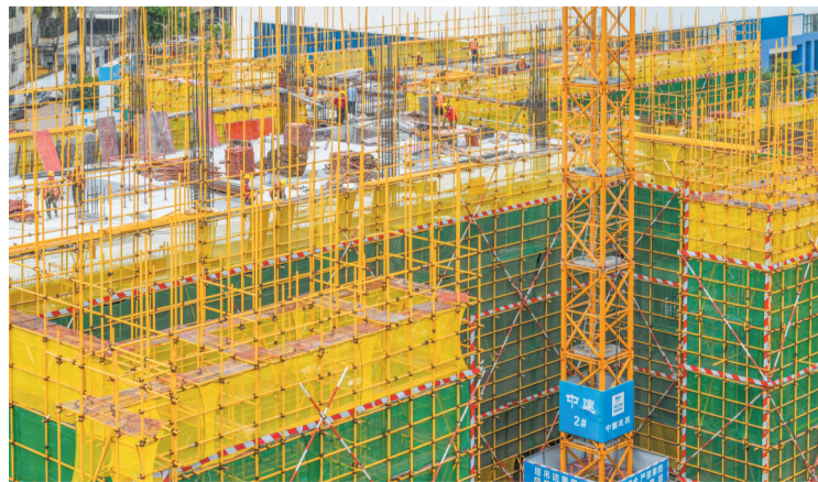
5月1日，在灵山中学改扩建项目现场一派繁忙的施工景象。本报记者 康登淋 摄
