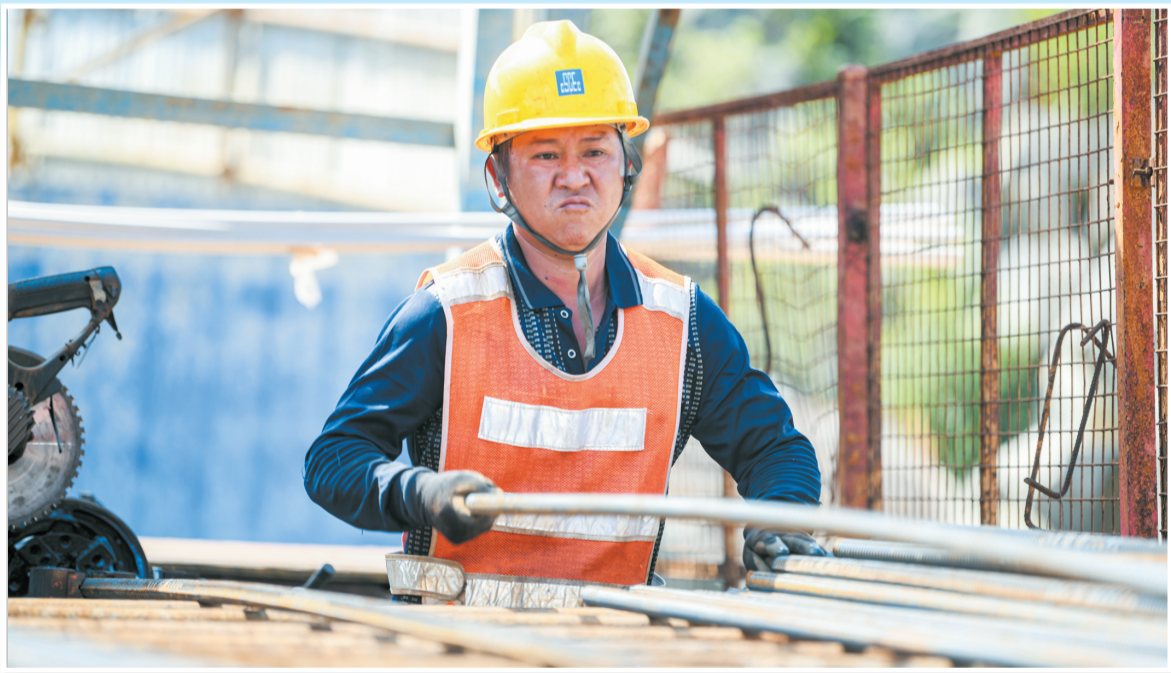
5月16日,在海南新能源汽车体验中心环岛首发驿站项目现场,施工人员正在加工钢筋。 本报记者 苏弼坤 摄
