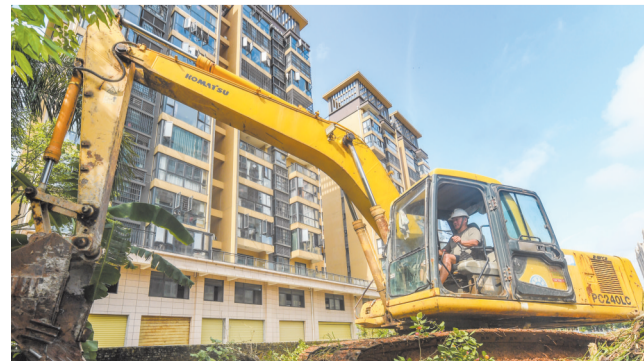
5月18日,在施工现场,工人正驾驶挖掘机清理地表。 本报记者 康登淋 摄
