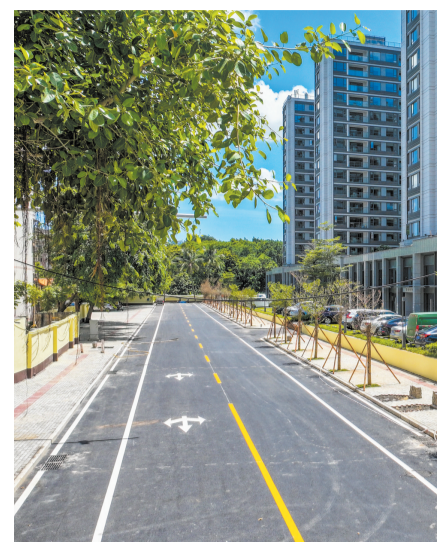
7月7日完工的龙华区金垦一横路。本报记者 康登淋 摄
