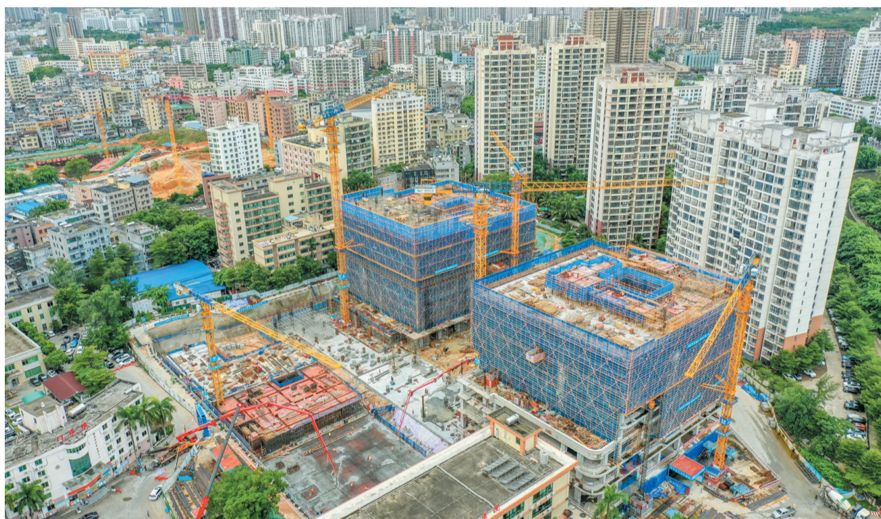
近日,海南省老年医疗中心(一期)项目现场,塔吊繁忙运转,工人有序作业。本报记者 孙士杰 摄
