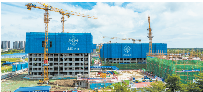
俯瞰建设中的海口横沟村城市更新项目(一期)。本报记者杨鹤摄
