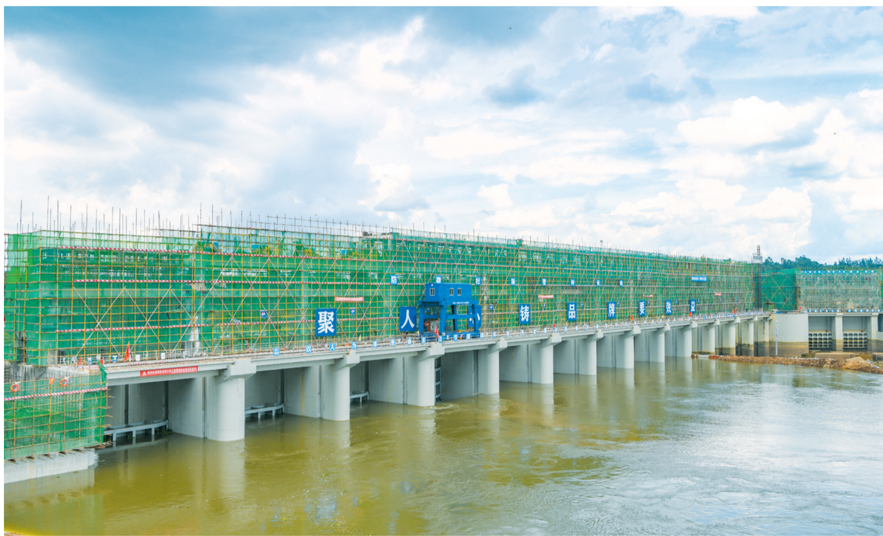
7月26日,南渡江龙塘大坝枢纽改造工程现场,拦河闸二期基坑全断面已经顺利过流。 本报记者 苏强坤 摄
