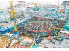
这是7月28日拍摄的中广核宁德核电站5 号机组主体工程开工现场(无人机照片)。当日, 中广核福建宁德核电站5号机组核岛浇筑第一罐 混凝土,标志着这个机组主体工程正式开工,宁 德核电项目二期工程建设序幕由此拉开。
