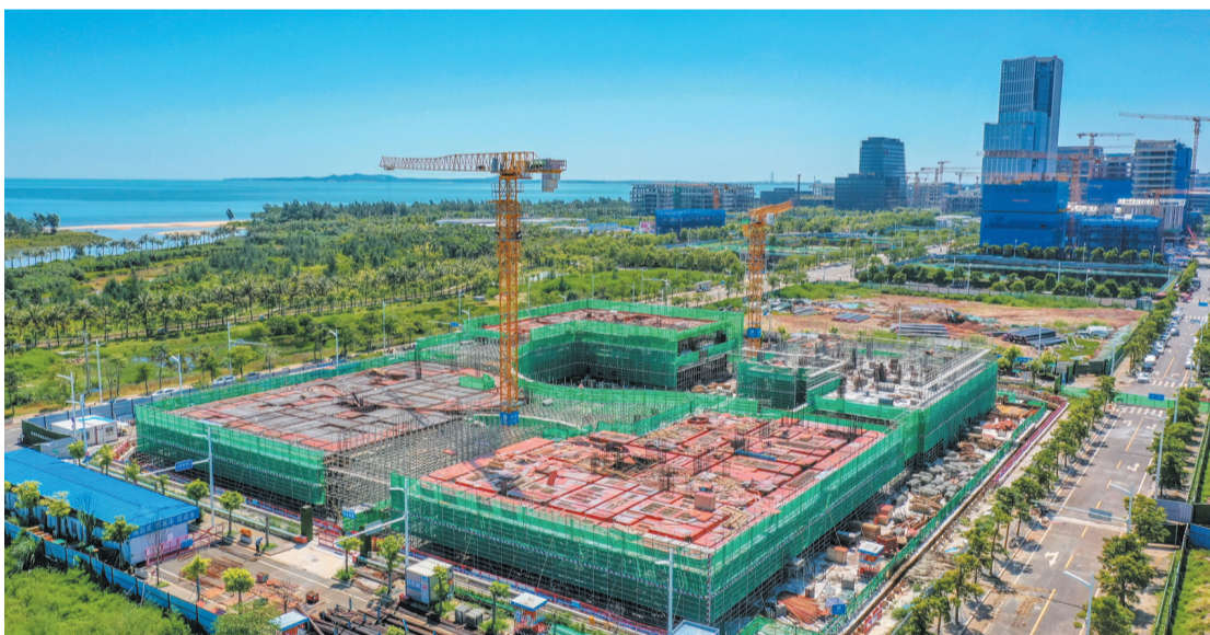
近日,江东智慧国际公寓B区项目住宅楼完成“正负零”工程节点。 本报记者 孙士杰 摄
