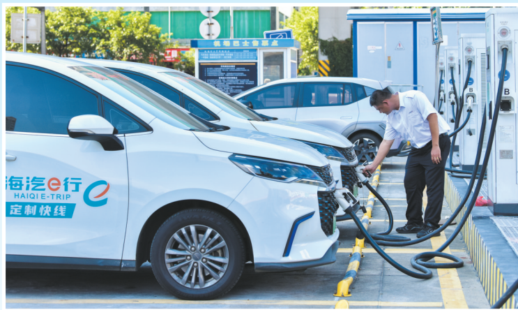
▲海口汽车西站站前广场设置了充电桩,方便站内新能源汽车充电,并向公众开放。
