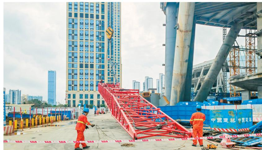
9月10日上午,海南中心项目开始安装重达22吨重的塔吊吊臂,安全有序推进项目复工复产。海口市融媒体中心全媒体记者 杨鹤 摄
