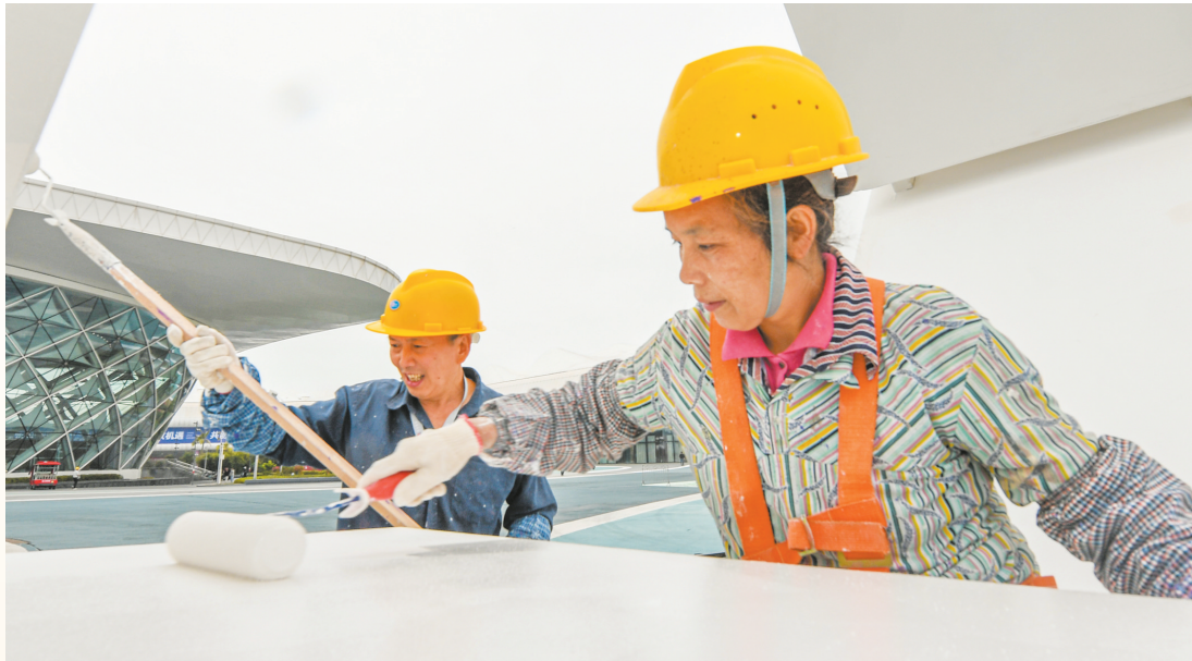
4月7日,在海南国际会展中心,工人对消博会设施进行粉刷。
