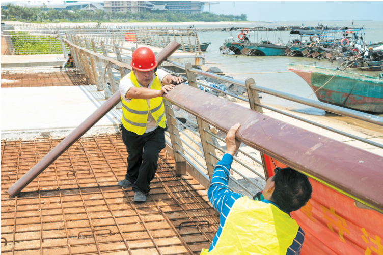
近日,在海口市岸线基础设施灾后应急修复工程现场,工人们正在加紧安装护栏。 本报记者 石中华 摄
