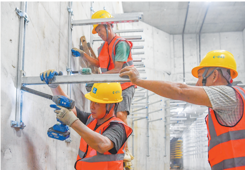
6月6日,海文南路市政化改造工程项目二期综合管廊内,施工人员在安装电缆支架。
