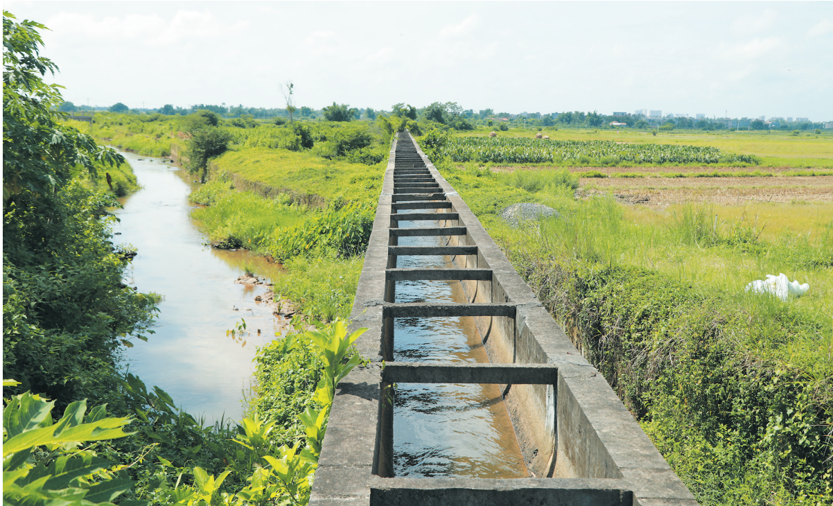
近日，在海口市秀英区东山镇玉下村，修复后的东寨水库灌沟渡槽已顺利通水。本报记者 石中华 通讯员 符志敏 摄
