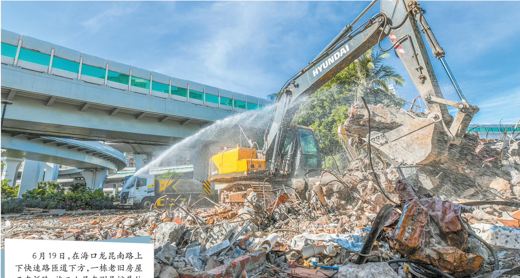
▲6月16日,在海口龙昆南路上下快速路匝道下方,施工人员进行驾驶机械设备拆除老旧房屋。
