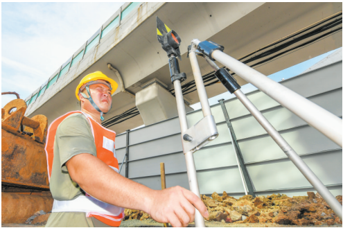
6月19日,在海口龙昆南路上下快速路匝道下方,施工人员进行桥墩桩位复测。
