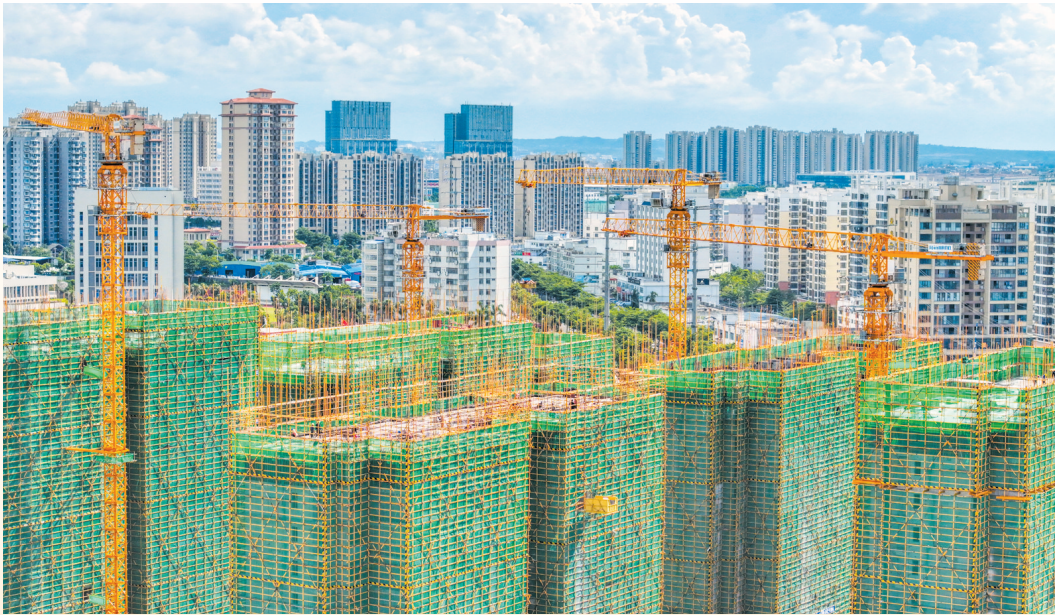
正在建设中的海虹化纤片区城市更新项目一期(嘉禾郡)。
