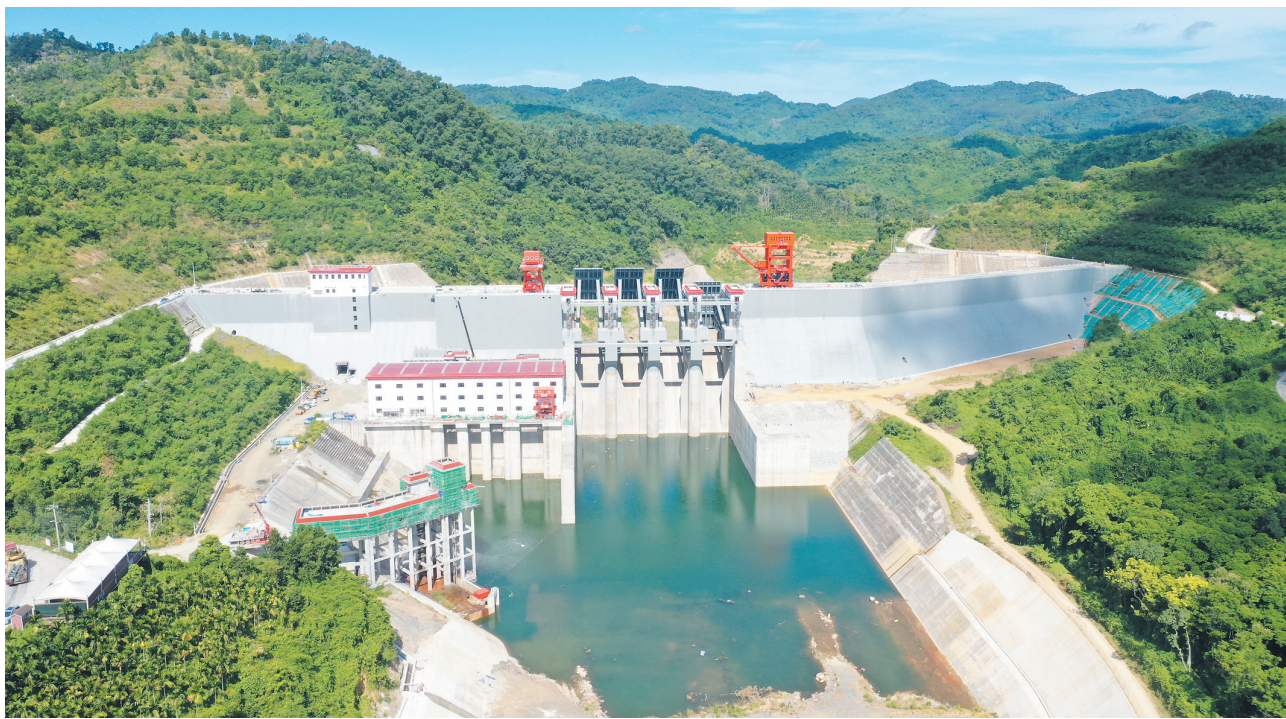
7月2日上午，南渡江迈湾水利枢纽工程正式下闸蓄水。
