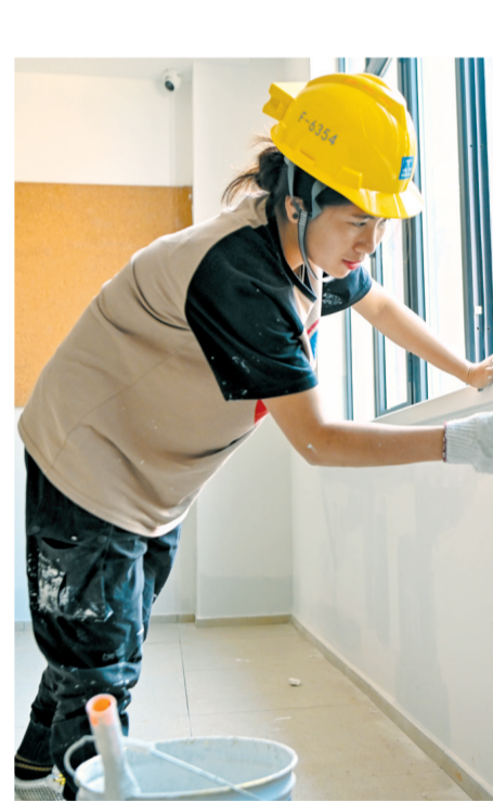
▲3月6日,工人正在室内刷漆。
