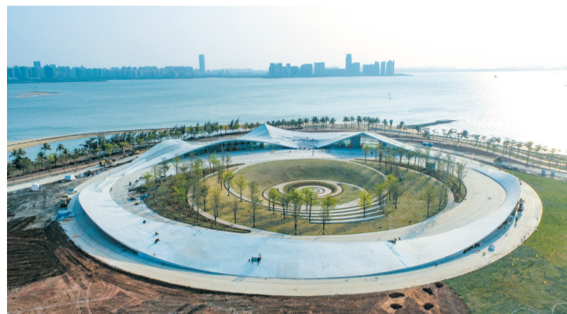
3月6日,航拍视角下的海口湾“天空之山”项目施工现场。 本报记者 孙士杰 摄
