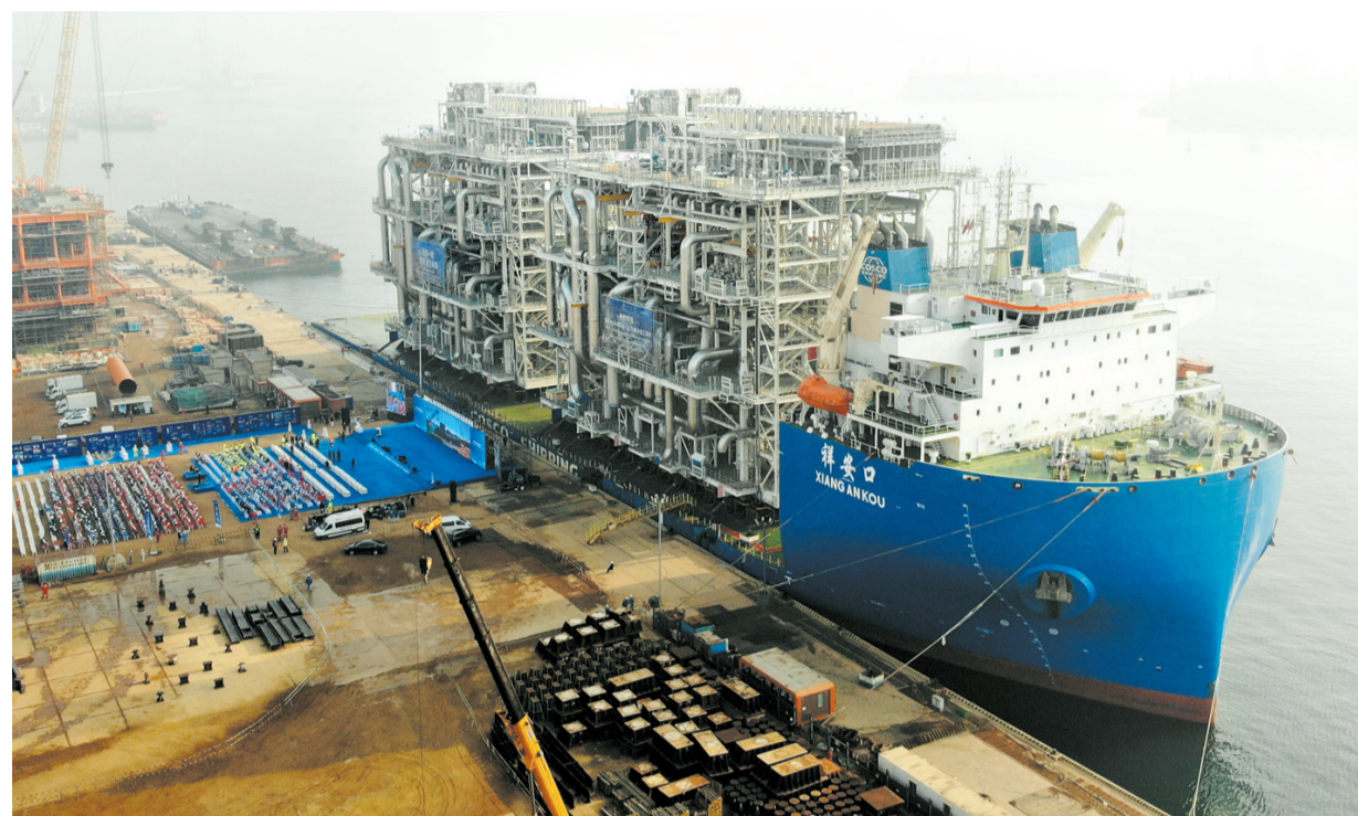
3月7日,加拿大LNG项目最后两个核心工艺模块在青岛场地装船(无人机照片)。当日,由中国海洋石油工程股份有限公司承建的又一超大型国际能源装备——加拿大LNG(液化天然气)项目的最后两个核心模块在青岛场地完工装船,至此,该项目中由我国承建的模块全部顺利交付。交付仪式上,加拿大液化天然气公司代表现场颁发由全球建筑业协会授予的AWP(高级工作包)专项奖,对项目全过程数字化、数字化、4D可视化应用管理取得的优异创新业绩进行认定,标志着由中国承建所有模块均达到设计及验收要求,我国在超大型LNG模块化工厂一体化联合建造技术能力方面已走在国际前列。 新华社记者 李紫恒 摄
