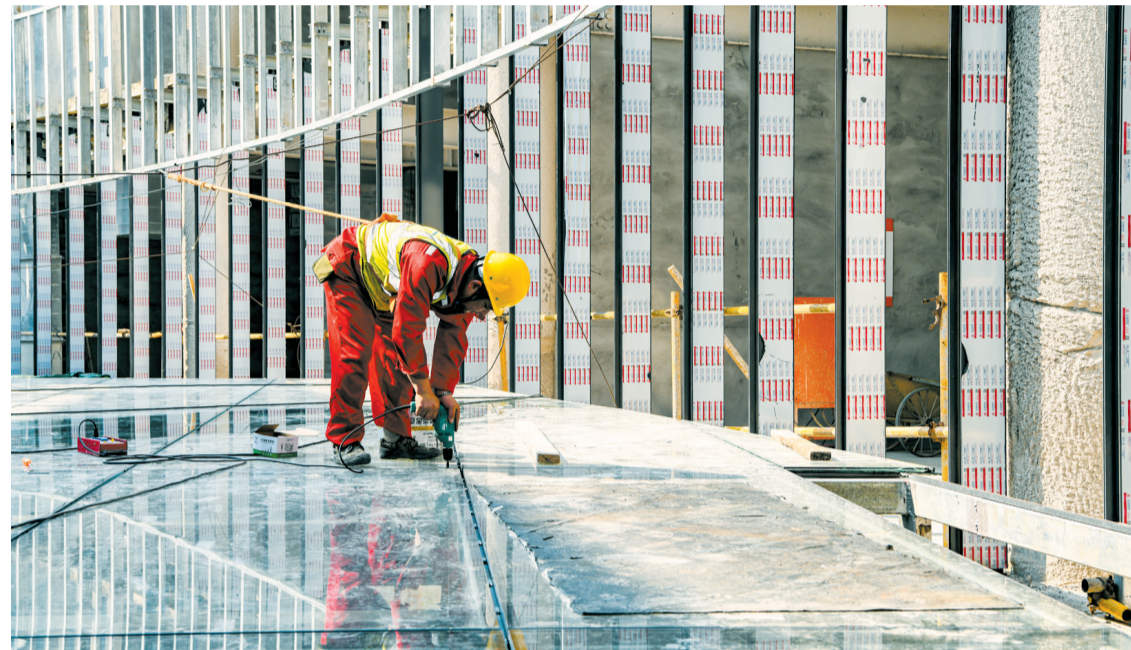
3月25日,在海南省非遗展示中心项目的中庭玻璃顶处,施工人员正在固定最后几块玻璃。本报记者 苏弼坤 摄
