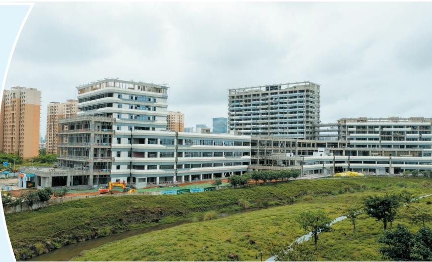
5月14日,海南省妇幼保健院异地新建项目在进行室内装修、机电安装等施工作业。 本报记者 石中华 摄
