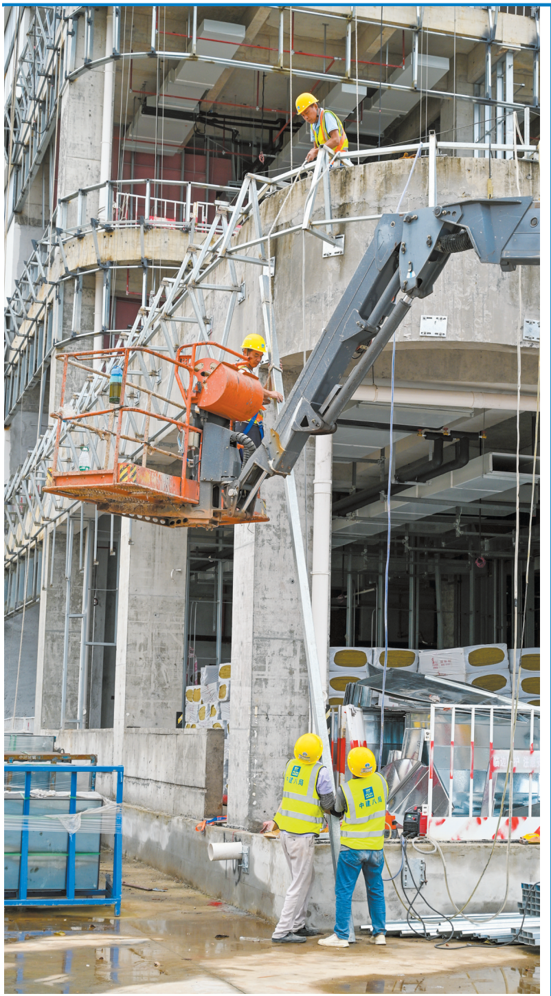
5月14日,海南省妇幼保健院异地新建项目在进行外立面幕墙施工。 本报记者 石中华 摄
