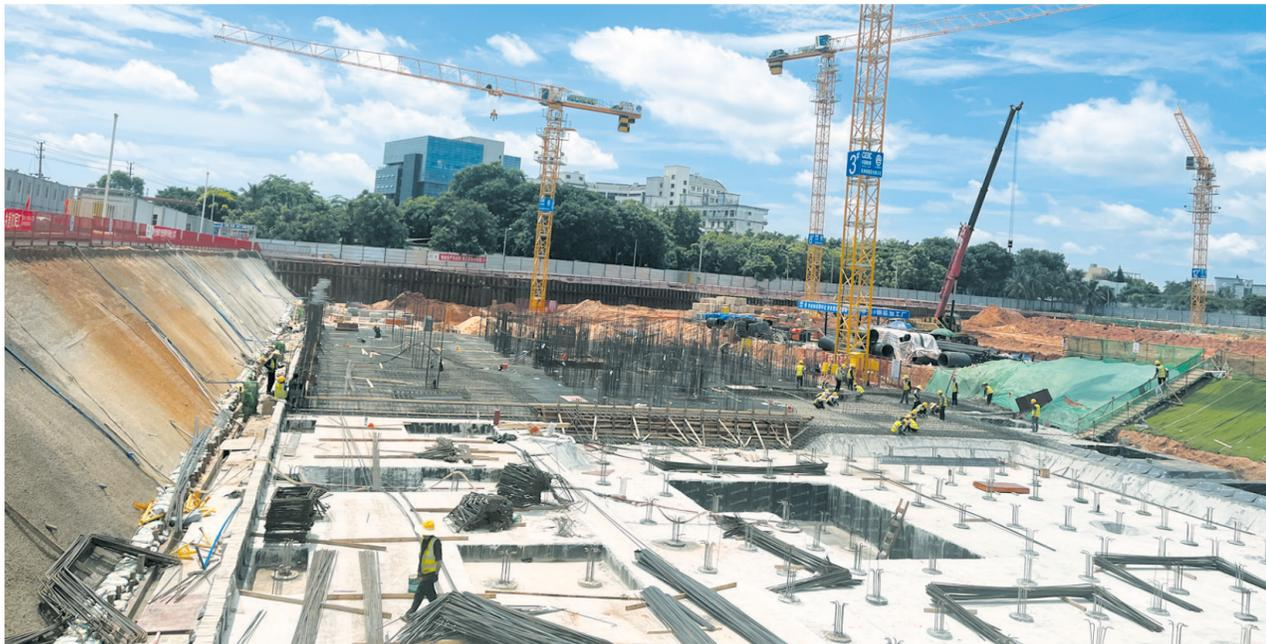
海口桂府佳苑安居房项目5号楼地下室垫层已经完成,6号楼正进行筏板施工。
