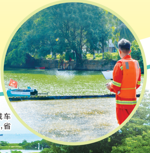
▲环卫工人在东西湖上操控无人打捞船进行水上保洁作业。
