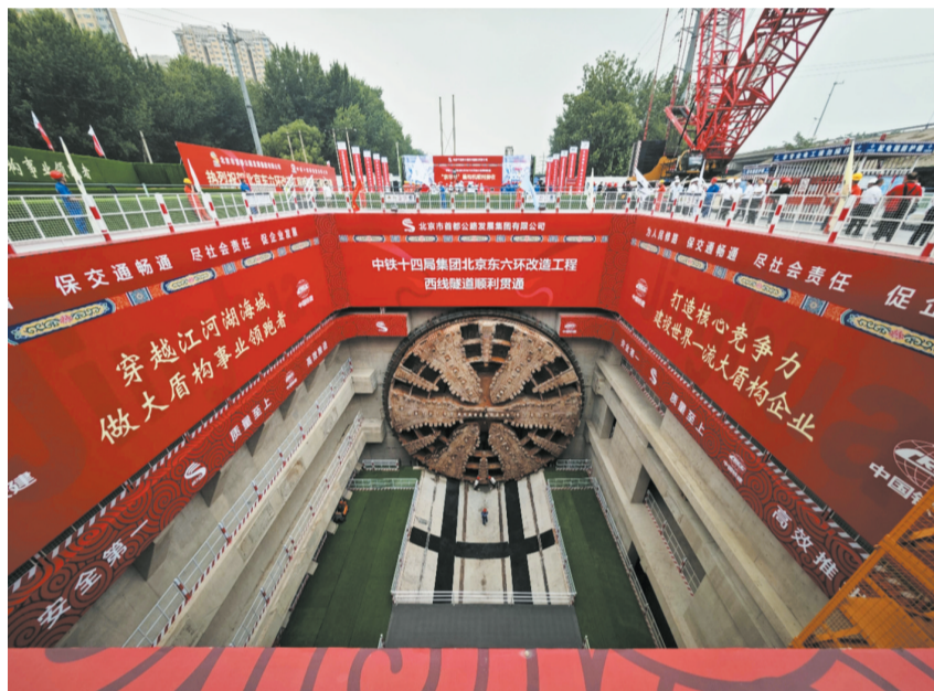
6月28日,国产最大直径盾构机——“京华号”盾构机出洞,由中铁十四局承建的北京东六环改造工程西线隧道顺利贯通。这是目前我国最长盾构高速公路隧道,标志着这一国家级创新工程取得重大进展。新华社记者 邢广利 摄
