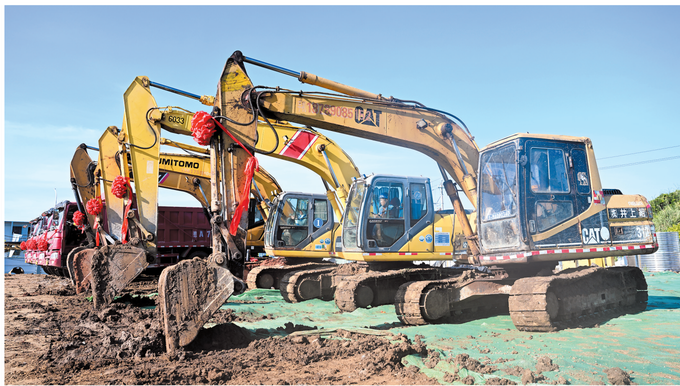
6月29日,在海南自由贸易港建设项目2023年度第二批集中开工活动主会场,工程车辆整装待发,准备开工。
