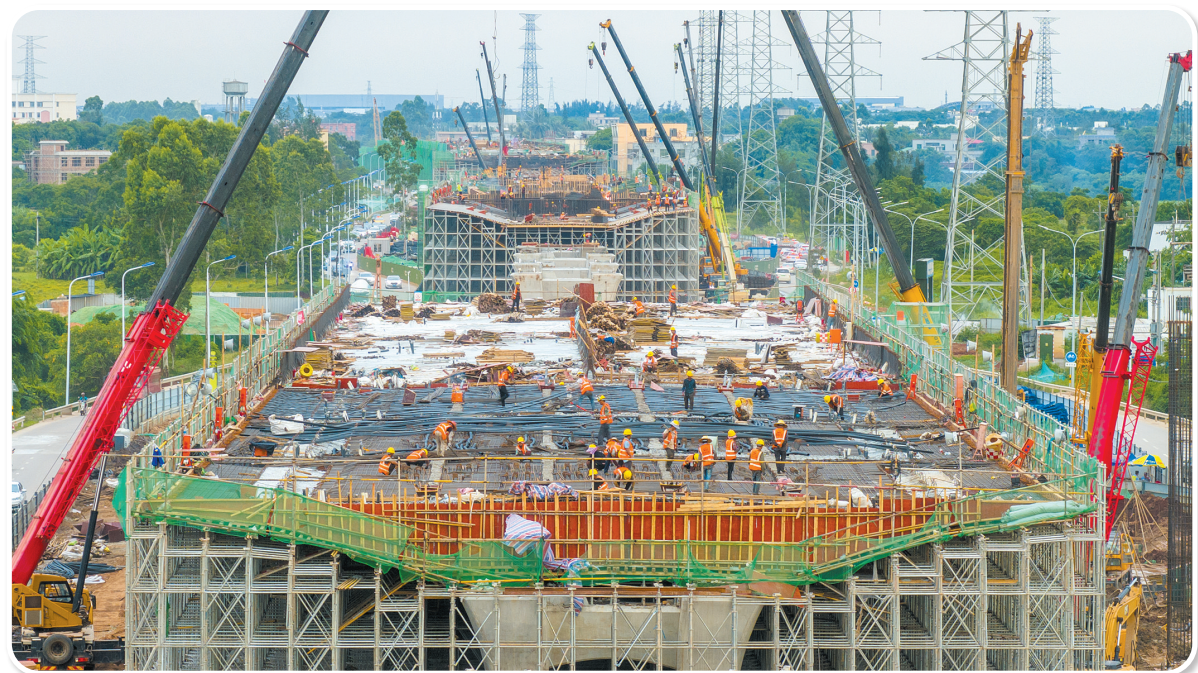
海口市江东新区快速通道项目施工现场一片繁忙。 本报记者 杨鹤 摄
