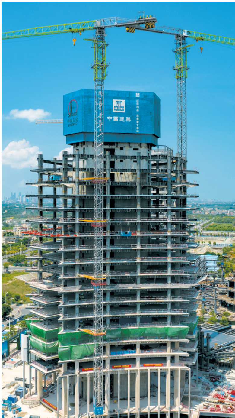
中国石化自贸大厦项目核心筒已建至22层,成为江东新区CBD第一高楼。
