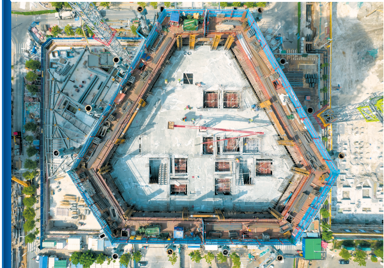
航拍正在加快施工中的中国石化自贸大厦项目。
