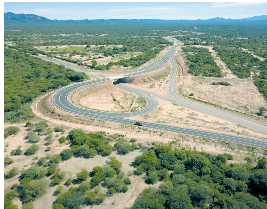
这是2023年4月22日拍摄的玻利维亚埃尔埃斯皮诺公路(无人机照片)。由中国中铁股份有限公司承建的玻利维亚埃尔埃斯皮诺公路项目日前在该国圣克鲁斯省博伊韦市举行竣工通车仪式。这条公路通车后将推动玻东部经济发展，促进区域互联互通。新华社发
