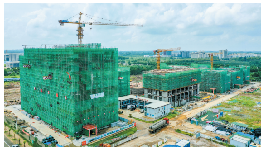
目前,位于海口国家高新区美安生态科技新城的东湖高新海口生物城首期厂房主体结构正在加快建设之中。本报记者 康登淋 摄
