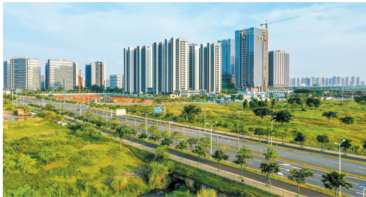
近日，海口复兴城二区国际数字港项目多栋写字楼完成主体结构封顶。 本报记者 康登淋 摄
