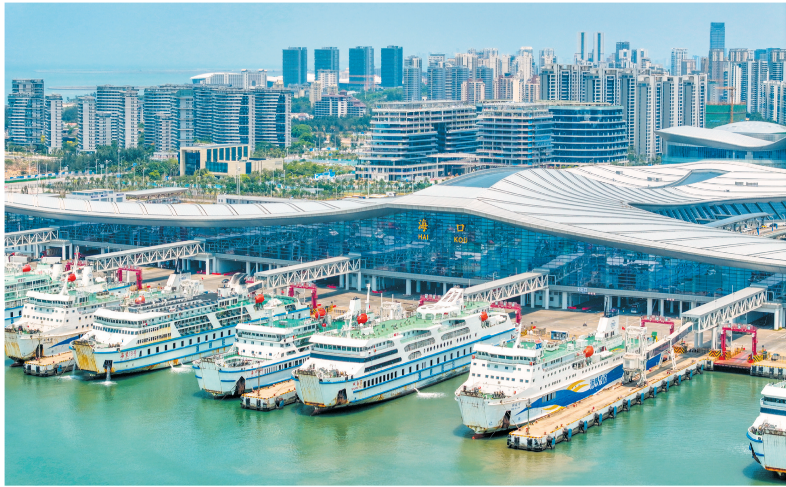
作为琼州海峡港航一体化的重点推进项目,海口新海客运综合枢纽集港口候船、登离船、口岸查验、枢纽商业和交通“零换乘”等功能于一体,进一步提升了车辆、旅客过海效率。“五一”假期,从空中俯瞰海口新海客运综合枢纽站,码头船舶往来频繁。 本报记者 康登淋 摄
