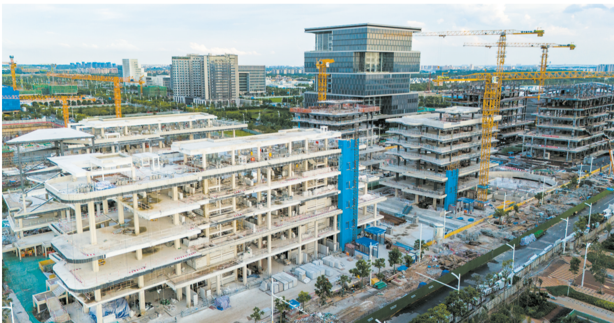
5月27日,航拍江东天地项目现场。本报记者 苏弼坤 摄
