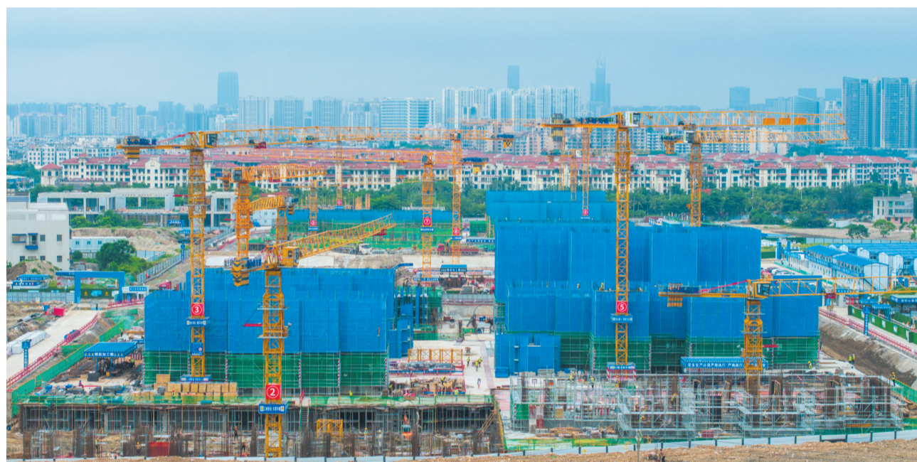
5月31日，俯瞰正在加快建设中的海口横沟村城市更新项目(一期)施工现场。
