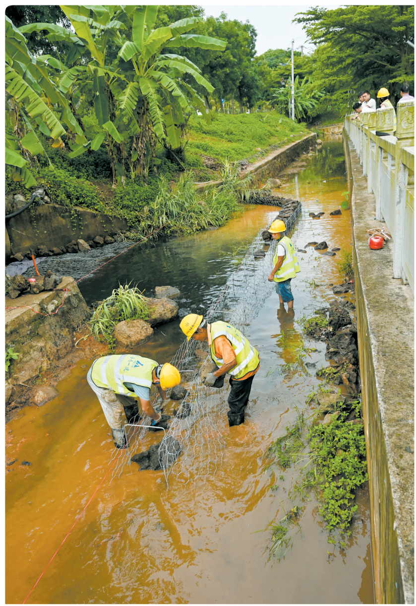
5月24日,在秀英区富教村东侧排水沟里,工人在铺设过滤隔离带。
