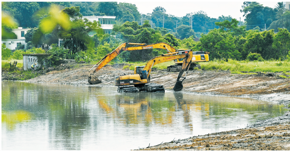
5月24日,在美兰区红丰村委会道孟河,机械轰鸣,工人正在进行清淤。
