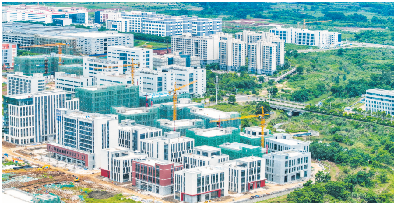
6月4日,俯瞰位于海口国家高新区美安生态科技新城的东湖高新海口生物城项目全貌。本报记者 康登淋 摄
