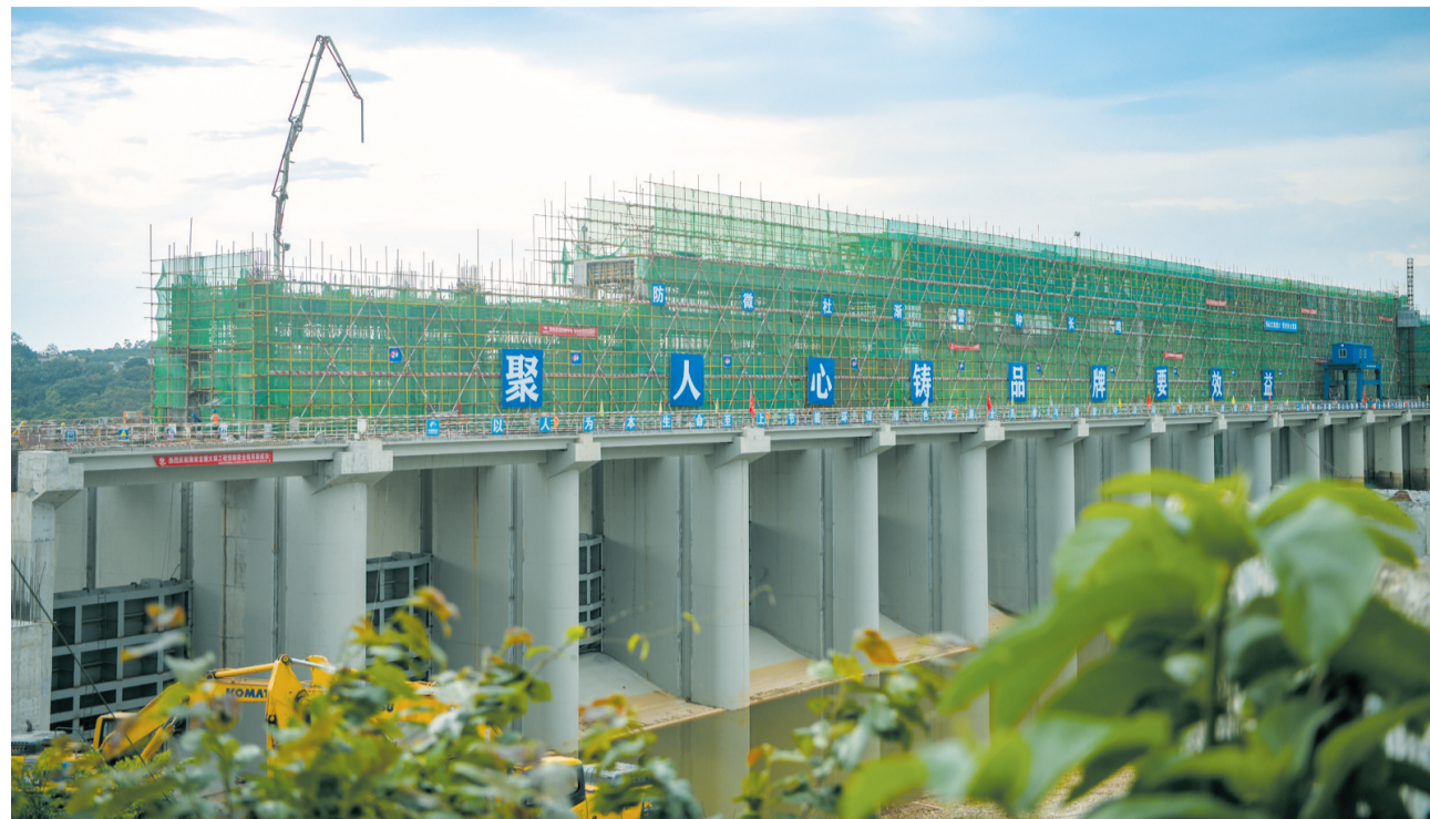
南渡江龙塘大坝枢纽改造工程项目拦河闸实现全线封顶。
