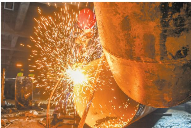
6月7日,在江东新区高品质饮用水水厂项目现场,施工人员正在焊接输水管道。 本报记者 孙士杰 摄
