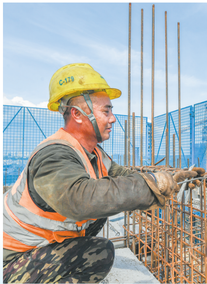
6月14日,在永桂花园安居房A区项目现场,施工人员正在捆扎钢筋。 本报记者 孙士杰 摄
